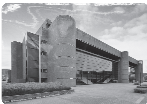
長野県民文化会館
